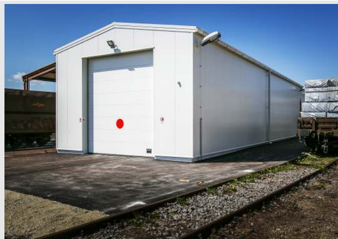
Nova hala H5 s kanalom dolžine 35 m
